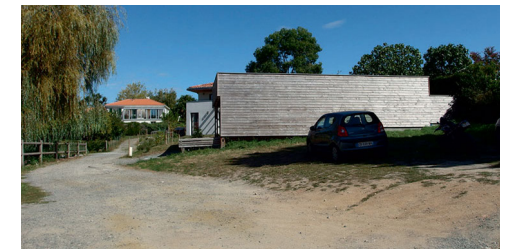
Photos de l'existant
